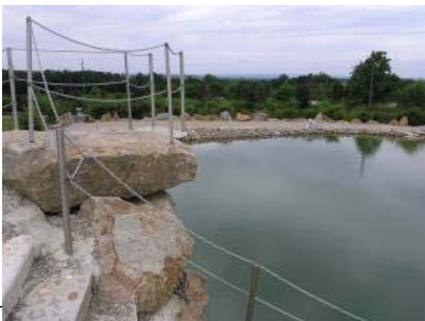
Abb. 1.2.3 Teich 3 der Schwimmteichanlage mit Sprungturm.
