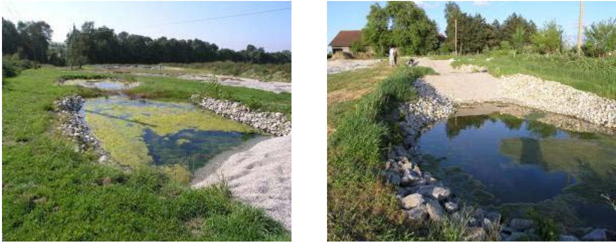
Abb. 1.4.1. Das linke Bild zeigt die untere Retentionsbeckenkaskade (RB2) mit dem mechanischen Filter in Form eines Kiesbetts im Vordergrund. Dahinter liegt ein zweites Becken gefüllt mit Wasser (=Zulauf), gefolgt von einem weiteren Wasserbecken (=Ablauf). Links von dieser Kaskade liegt der Schwimmteich 4, dessen Damm hier am linken Bildrand zu sehen ist. Das rechte Bild zeigt dieselbe untere Retentionsbeckenkaskade in umgekehrter Blickrichtung, d.h. das Ablauf-Becken dieser Kaskade im Vordergrund.
