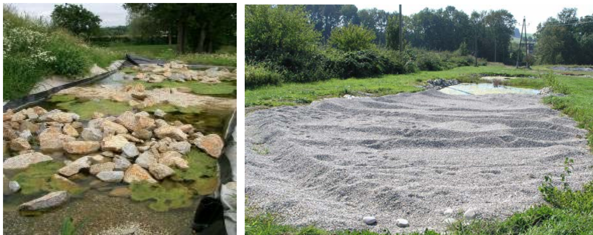
Abb. 1.4.4.1 Verteilung der EM auf das Retentionsbecken (RB1) oberhalb von Teich 1 und 2 (linkes Bild) sowie das Kiesbett der Retentionsbecken RB2 (rechtes Bild).
